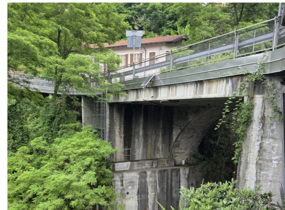
Ponte Via Cuboni
