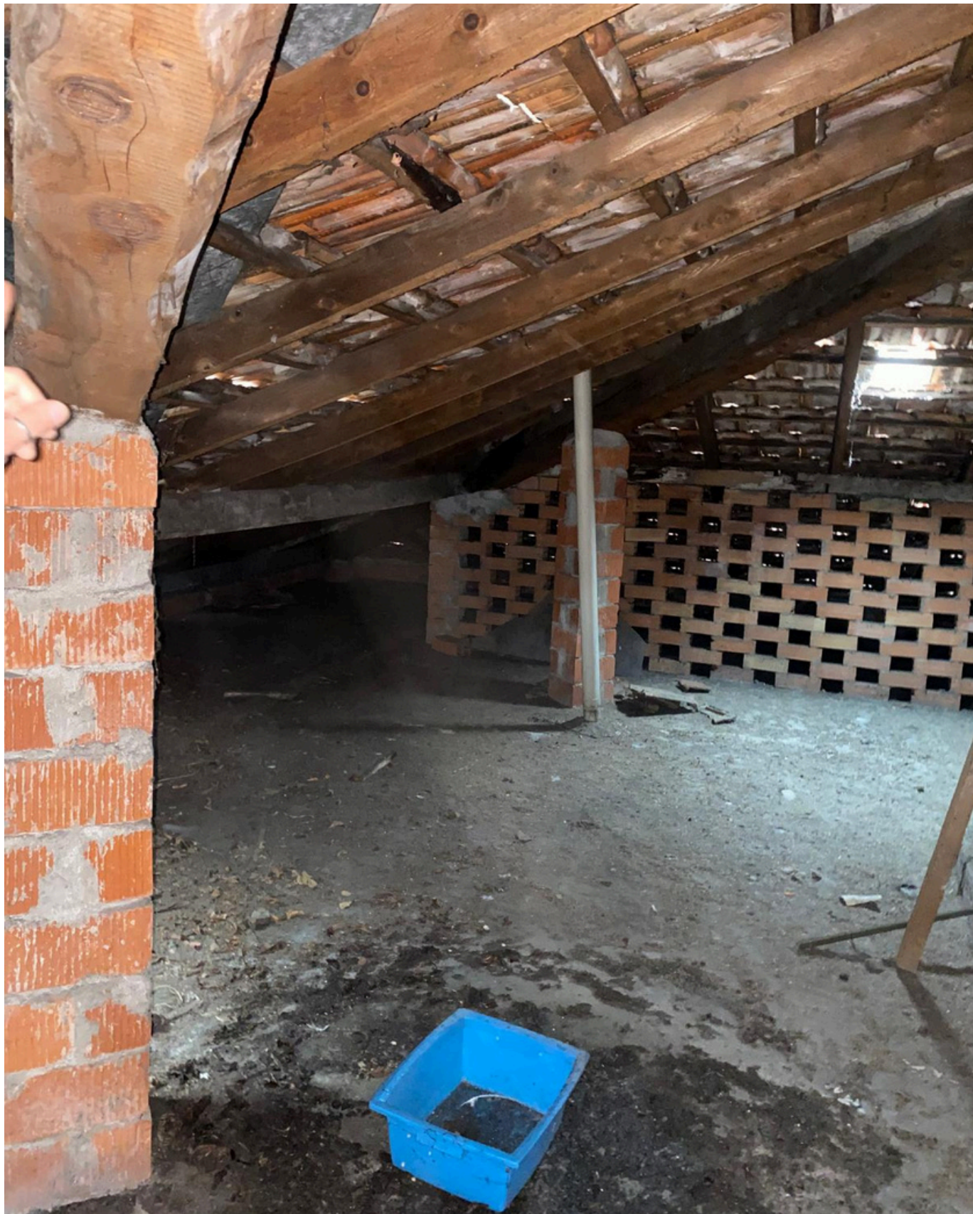
Tetto Scuola dell'Infanzia Della Rossa
